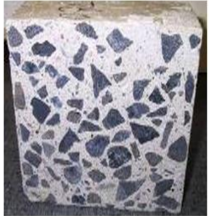
Hasil beton yang tidak bagus (Tidak kompak)
