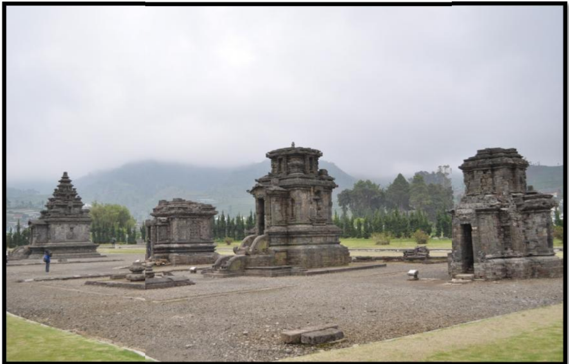
Gambar 6.3 Kompleks Candi Arjuna, Dieng Plateau Sumber: Dokumentasi M. Husen Hutagalung
